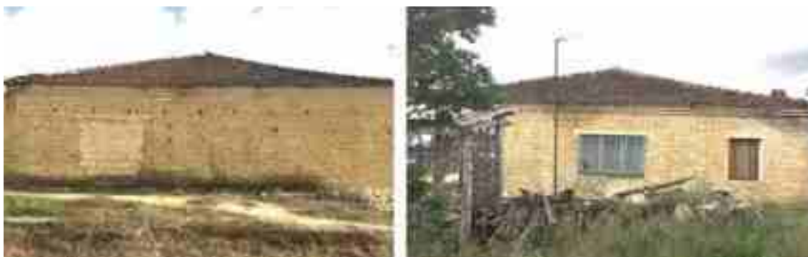
FIG 25- Dëmtime nga Uljet Diferenciale
