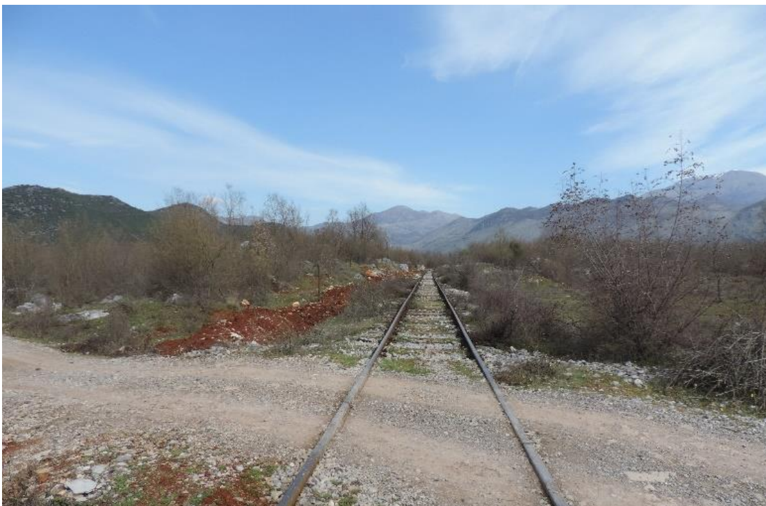
Figure 6.34_Kalesa ne nivel ne fshtin Skac (km 133+370); Pamje J-V; Majtas: bimësia e pastruar për instalimin e një tubacioni uji; hekurudha kalon nëpër shkurre dhe parcela me kullota. Shkurret përfaqësohen kryesisht nga shkoza orientale. Kuota vertikale është shumë e ulët; hekurudha ndodhet 950 m nga kufiri I RMN dhe 2.1 km nga bregu i liqenit; një terren kodrinor ndan linjën hekurudhore nga bregu i liqenit
