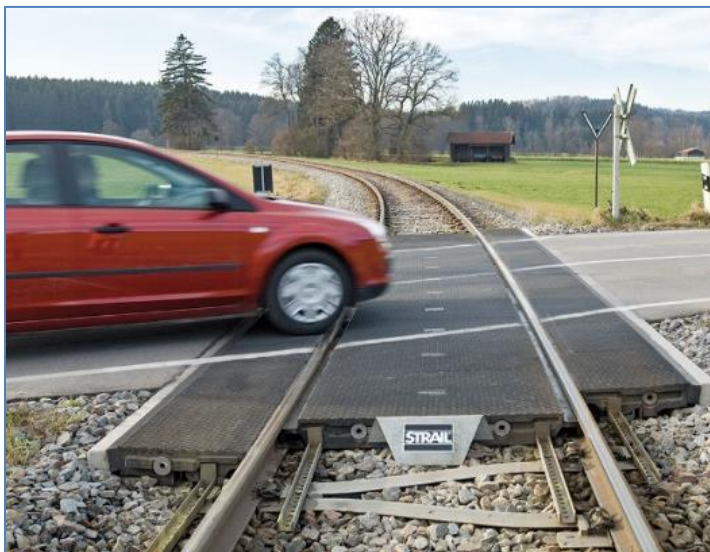
Figure 2.7_ Teknika "strail" per shtrimin e rruges ne kalesat ne nivel
