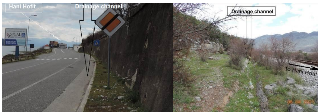
Figure 6.15 Hekurudha nga km 139 ne 140; Majtas: Kanal kullues ne te majte te hekurudhes; Djathtas: Kanal kullues ne te djathte te hekurudhes
