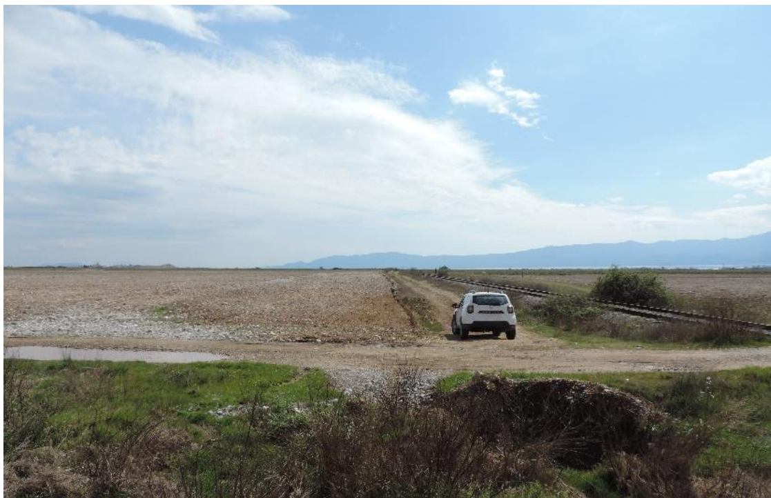
Figure 6.26_ Pamje V-J. Toka bujqesore permes nenzones se perdorimit tradicional; Km 127+000; Hekurudha kalon 1.4 km ne perendim te kufirit lindor te RMN dhe 3.5 km nga bregu i liqenit te Shkodres
